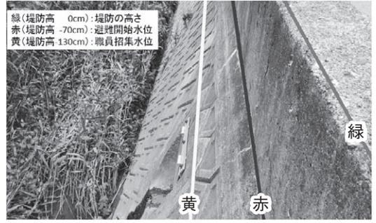
真はその時から用いている、堤防の水位毎の職員召集・避難の基準線である（右端の緑線が堤防上端）。
