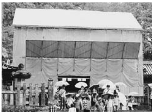
陽明門はH31年まで工事中
